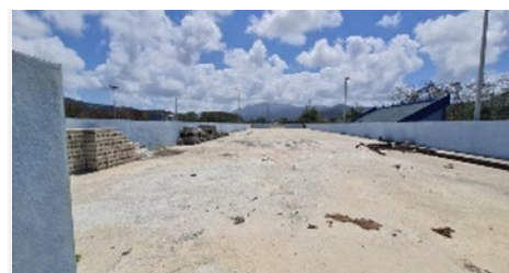
Fundamento para instalar estructura de acero
